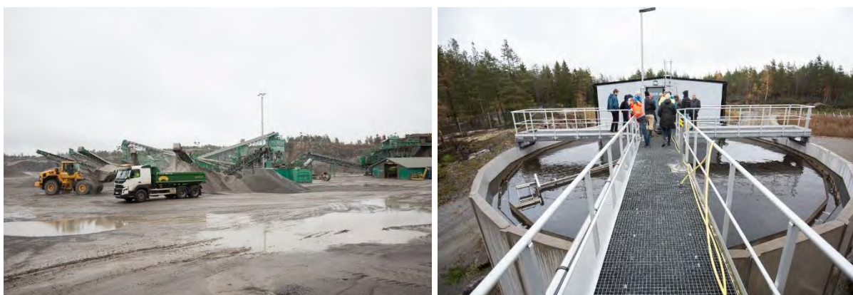
Bergkrossen och del av det lokala reningsverket som SVOA drifvar på uppdrag av SRV. Foto: Michael Wzdulski
